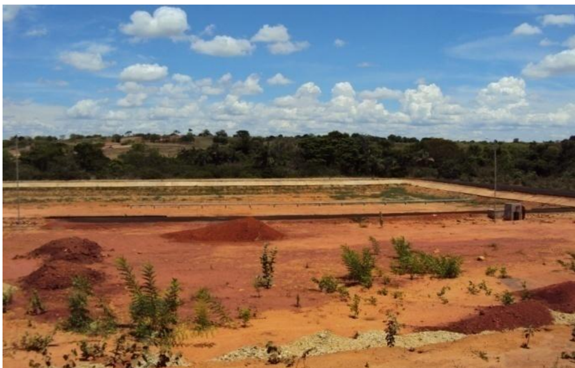
Figura 5.96 - ETE da sede de Montalvânia em fase de construção. Detalhe para a lagoa de estabilização e o rio Cochá ao fundo. Fonte: Ecoplan-Lume-Skill, 2011.
