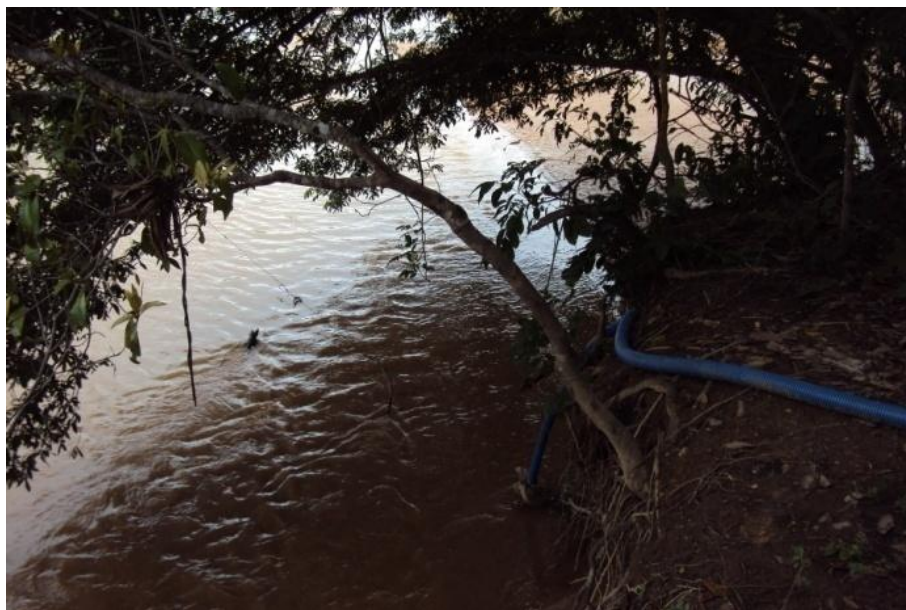
Figura 5.26 - Captação da localidade Prata no córrego Santa Catarina, no município de Chapada Gaúcha. Fonte: Ecoplan-Lume-Skill, 2011.
