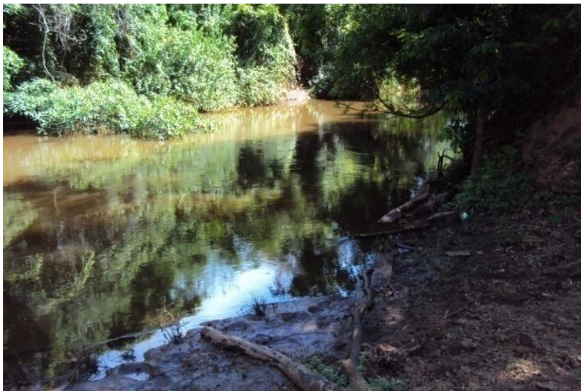
Figura 5.98 - Atual captação da localidade de Bananeiras, sem tratamento. Detalhe para a degradação do local, proveniente da dessedentação de animais. Fonte: Ecoplan-Lume-Skill, 2011.
