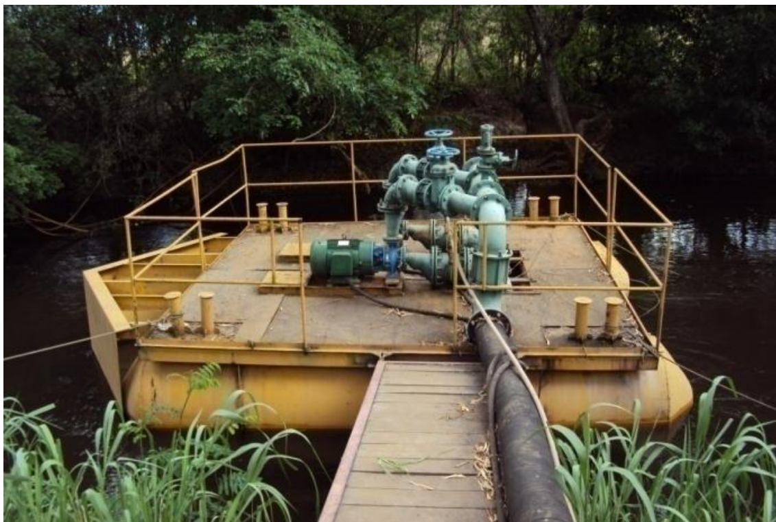
Figura 5.92 - Captação destinada ao abastecimento, após tratamento convencional, para a sede de Montalvânia. Fonte: Ecoplan-Lume-Skill, 2011.
