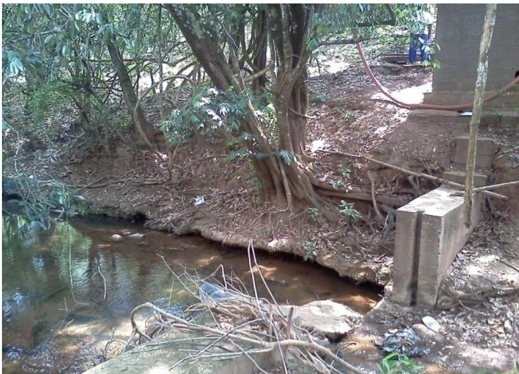
Figura 5.31 - Captação para abastecimento da localidade Vila de Fátima, sem tratamento, no riacho Bamburral em Brasília de Minas. Fonte: Ecoplan-Lume-Skill, 2011
