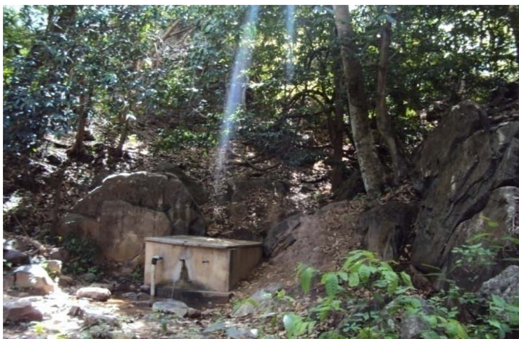
Figura 5.64 - Captação para consumo humano, sem tratamento, da localidade de Virgíneo em Miravânia. Fonte: EcoPLAN-Lume-Skill, 2011
