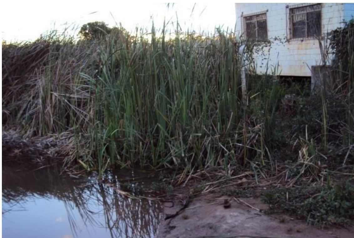
Figura 5.101 - Estrutura da COPASA para captação do distrito de São Sebastião dos Poções. Fonte: Ecoplan-Lume-Skill, 2011.
