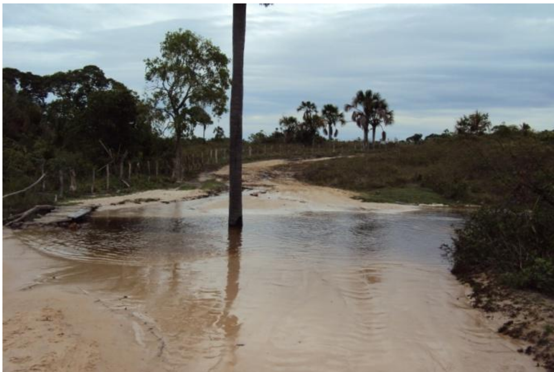
Figura 5.51 - Travessia sobre um afluente do riacho Borrachudo, a montante da captação da localidade Salto. Fonte: Ecoplan-Lume-Skill, 2011.
