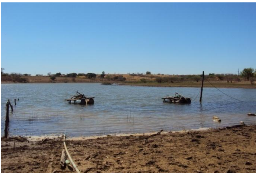
Figura 5.37 - Captações na barragem Santana de São Francisco para a localidade de Água Branca, Olhos D'Água e Cumbucas, todas sem tratamento. Fonte: Ecoplan-Lume-Skill, 2011.
