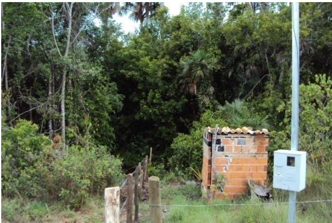
Figura 5.18 - Captação na vereda Quati para abastecimento da localidade Quati I em Chapada Gaúcha. Fonte: Ecoplan-Lume-Skill, 2011.
