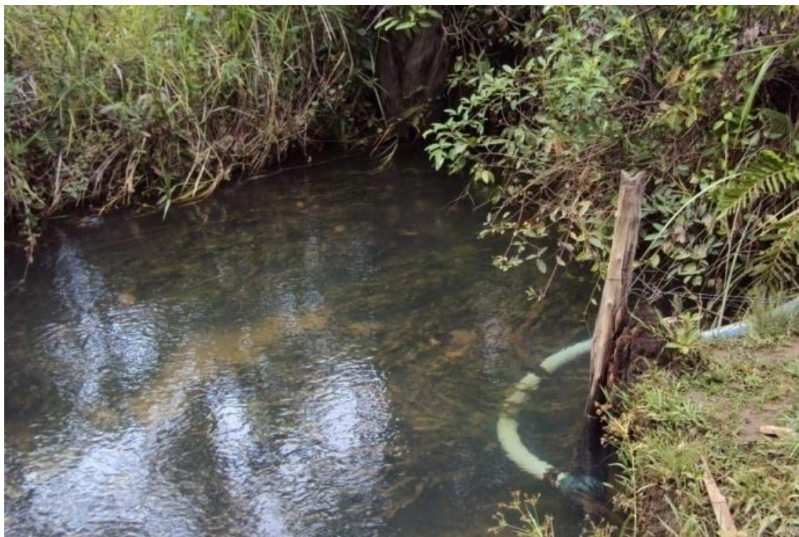
Figura 5.39 - Captação para o distrito de Várzea Bonita, distribuída sem tratamento. Fonte: Ecoplan-Lume-Skill, 2011.
