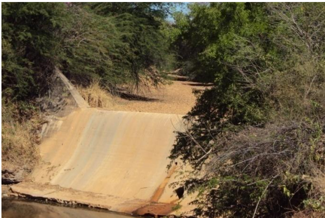
Figura 5.34 - Barramento de acumulação das águas e contenção de sedimentos. Detalhe para a quantidade de sedimentos retidos. Fonte: Ecoplan-Lume-Skill, 2011.
