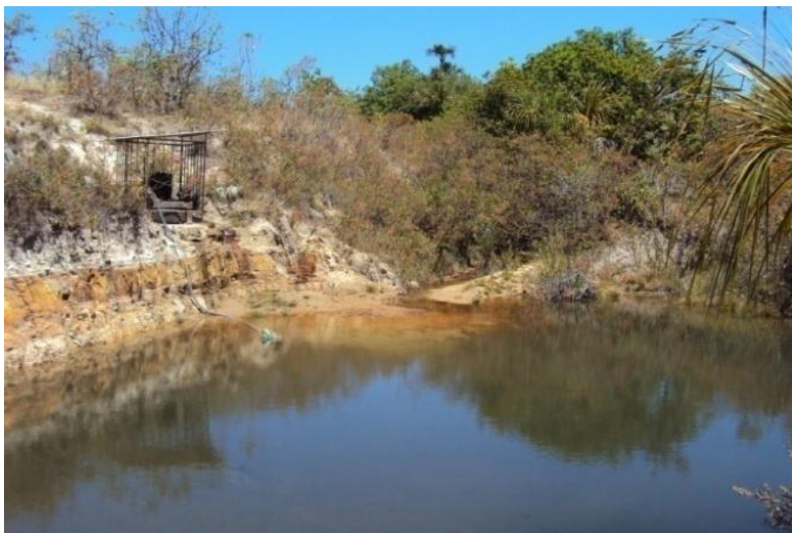
Figura 5.13 - Captação no afluente do córrego Vieira para abastecimento, sem tratamento, da localidade São Lourenço no município de Pintópolis. Fonte: Ecoplan-Lume-Skill, 2011.
