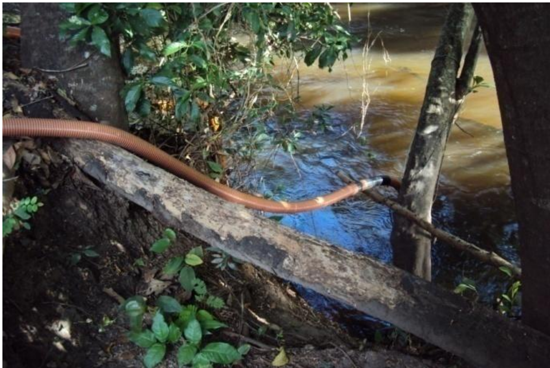
Figura 5.91 - Captação destinada ao abastecimento, sem tratamento, para a localidade de Mateira. Fonte: Ecoplan-Lume-Skill, 2011.
