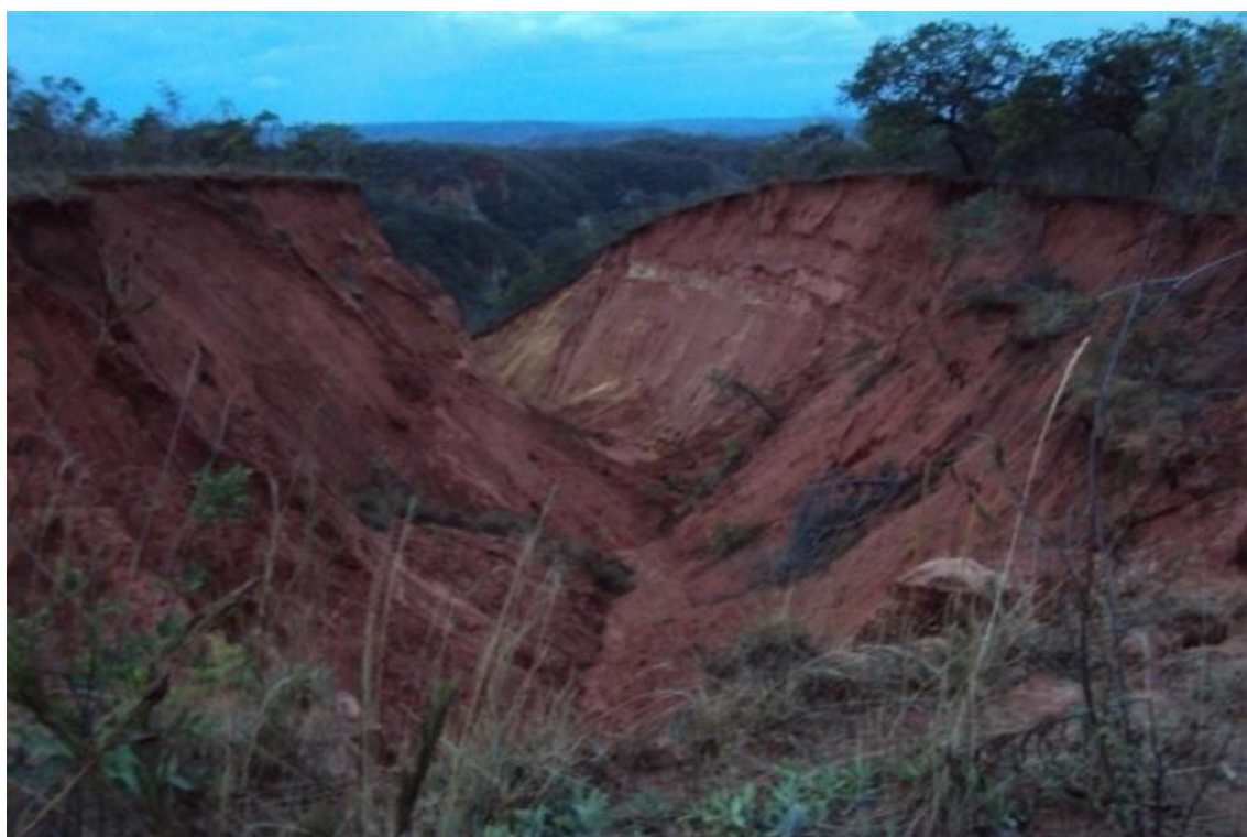
Figura 5.17 - Erosão localizada na cabeceira do rio Pardo em Chapada Gaúcha. Fonte: Ecoplan-Lume-Skill, 2011.
