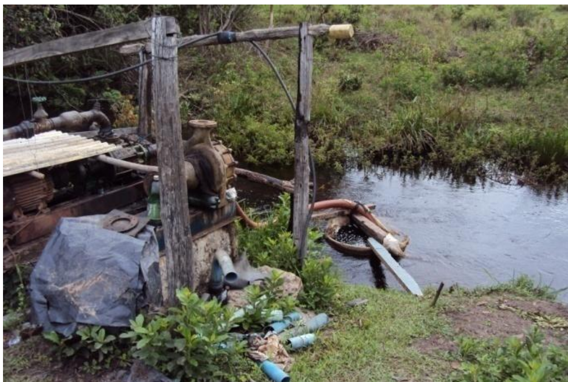
Figura 5.20 - Captação no córrego Jaboticaba para abastecimento do distrito São Joaquim em Januária. Destaque para a disposição inadequada de material. Fonte: Ecoplan-Lume-Skill, 2011.
