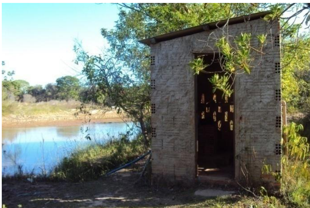
Figura 5.1 - Captação para abastecimento do assentamento Para Terra I no município de Pintópolis. Fonte: EcoPLAN-Lume-Skill, 2011.
