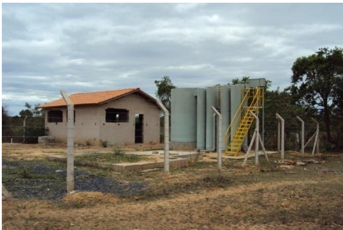
Figura 5.45 - Estação de tratamento de água, com tratamento convencional, em fase de construção na localidade Pandeiros. Fonte: Ecoplan-Lume-Skill, 2011.
